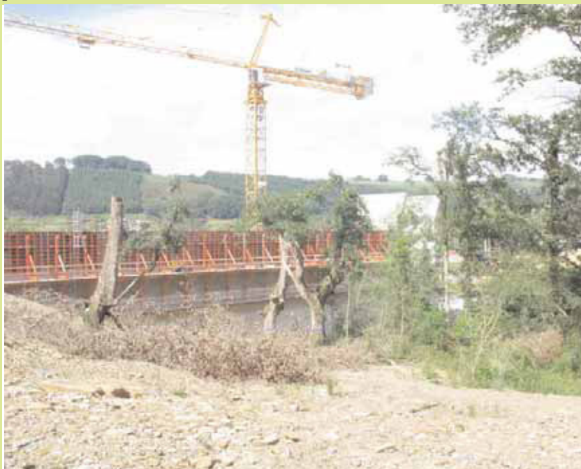
Photo 1. Barrage en construction. Un investissement de taille, pour une mise en sécurité de zones inondables à fort potentiel de développement urbain. Mais n'aurait-il pas été plus simple de déplacer la cible ?
